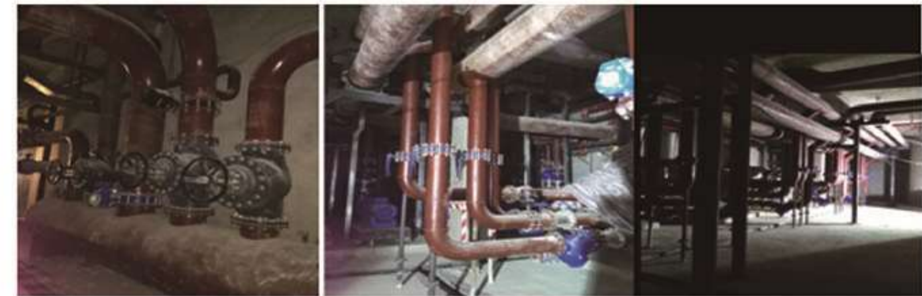
机房设备及管道现场预制...装配式施工实况二
