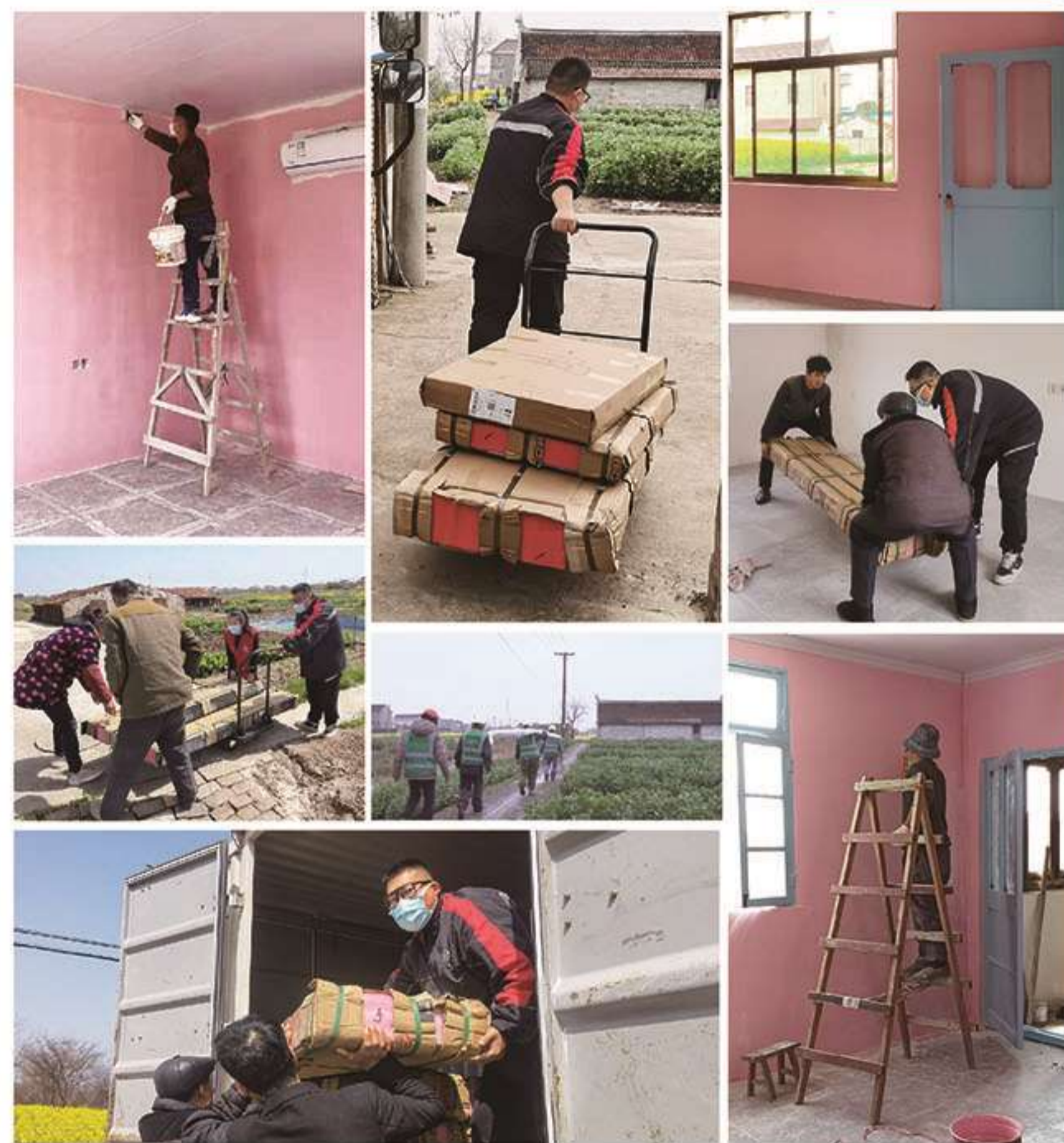
施工过程记录
