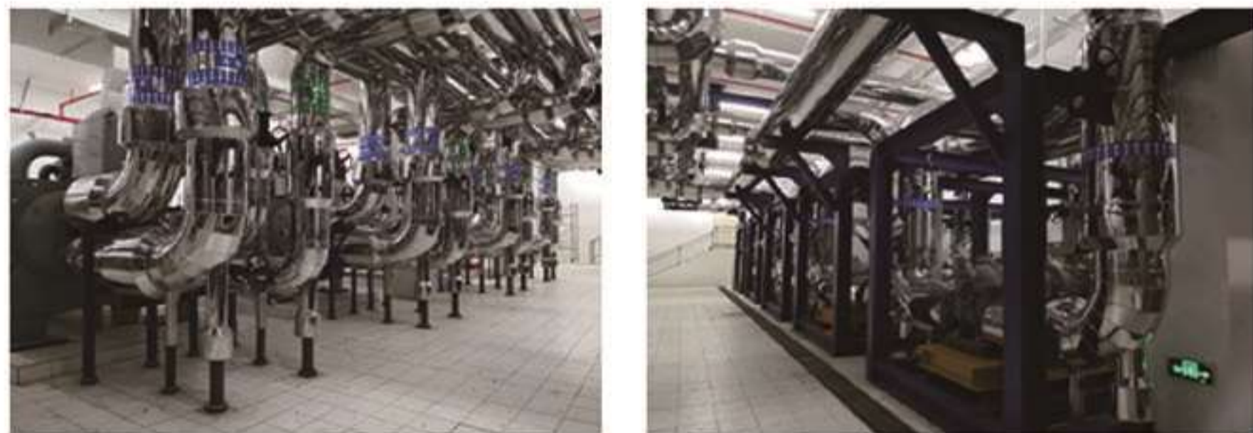
机房模块及管道装配---现场完后效果图四
