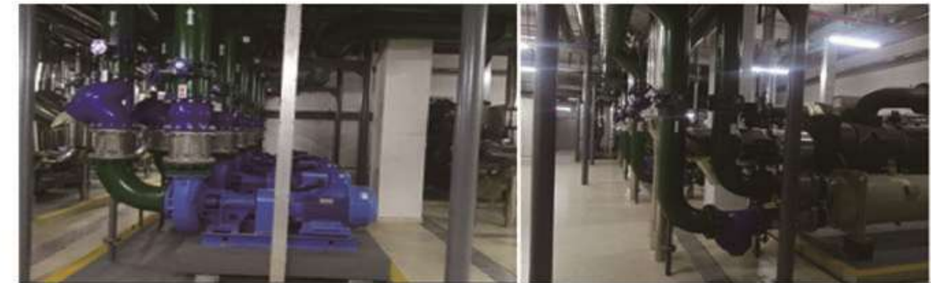
机房设备及管道现场预制...装配式施工实况一
