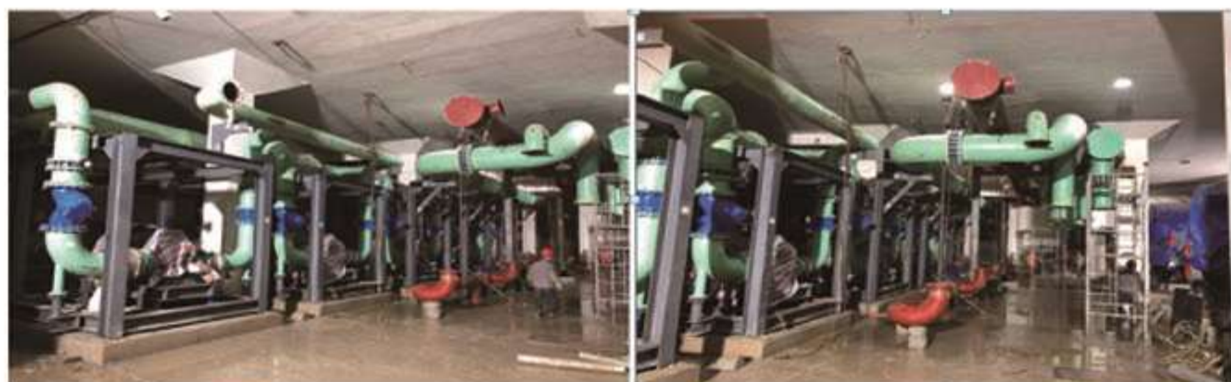
机房模块及管道装配---现场装配实景图三
