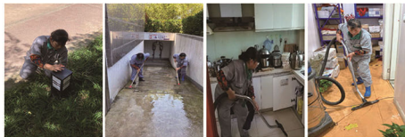
工程维修员——袁根宝
